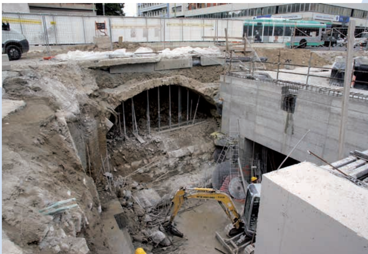
Resti archeologici emergono nel cantiere per la costruzione della stazione S. Faustino della metropolitana di Brescia, nel 2011.
