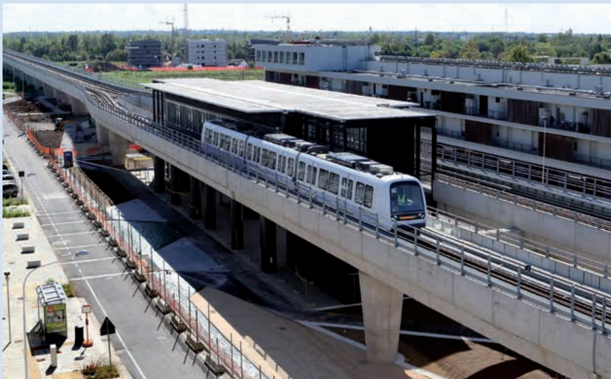
Un convoglio della metropolitana di Brescia, nel tratto in viadotto, alla stazione di Sanpolino durante i viaggi di collaudo.
