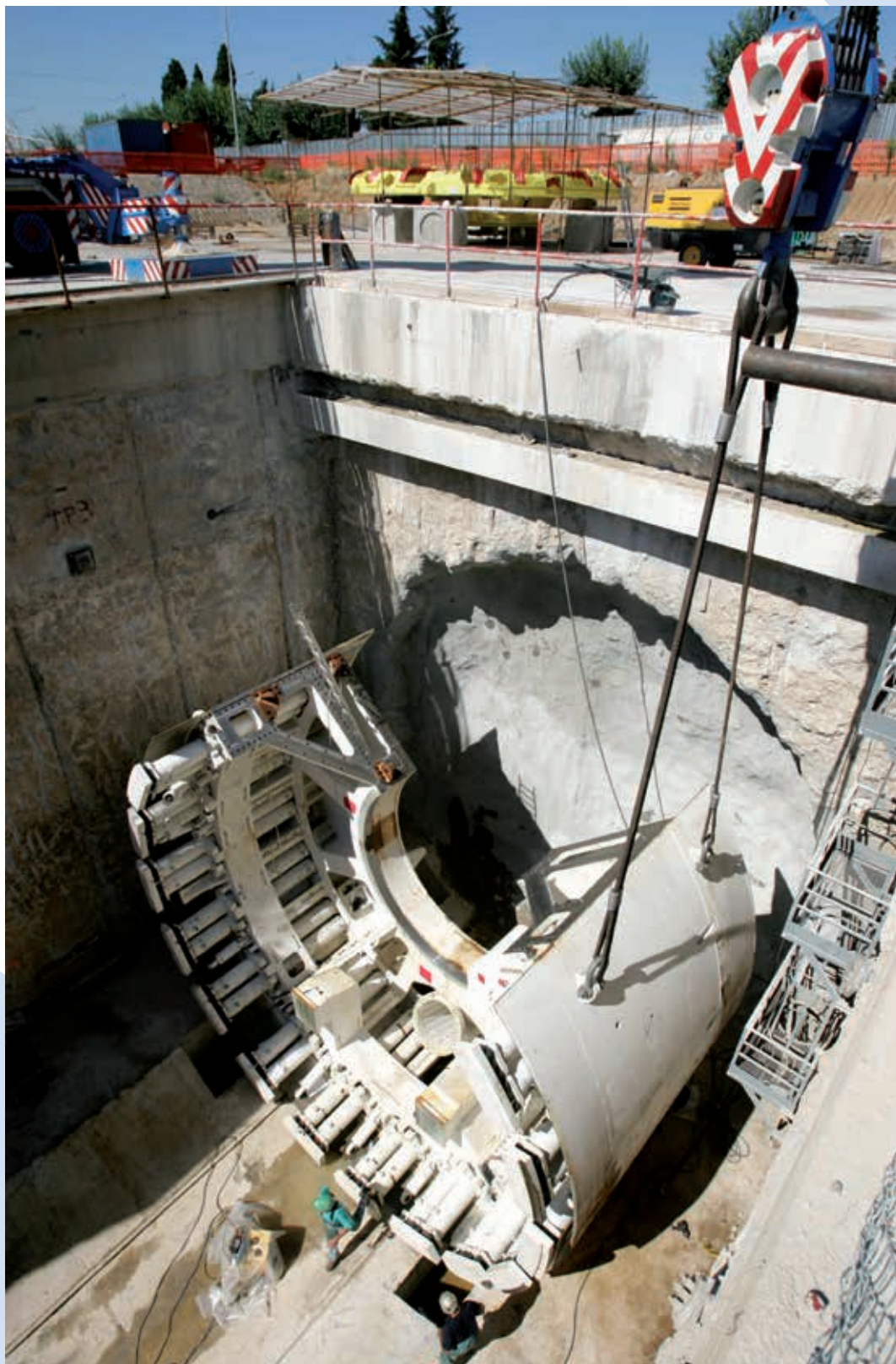
Montaggio della cosiddetta “talpa”, la macchina per lo scavo in galleria sotterranea utilizzata nella costruzione della metropolitana di Brescia (2007).
