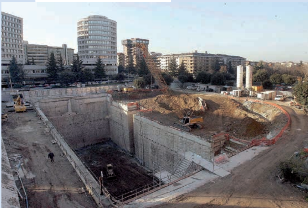
Scavi per la costruzione della stazione Brescia Due della metropolitana.
